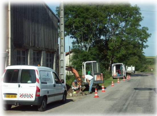
Changement des branchements avant le remplacement de la conduite.
