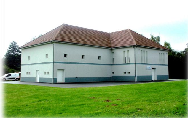
Station de pompage et traitement d'Uzemain
