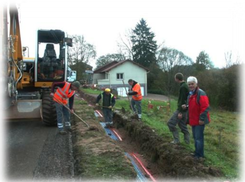
Changement des conduites effectué par le personnel à Uzemain centre à l'occasion de l'enfouissement d'un réseau EDF.
