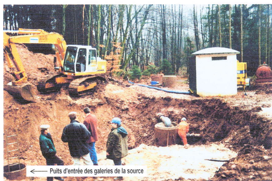
Travaux de réhabilitation de la source d'Uzemain.
